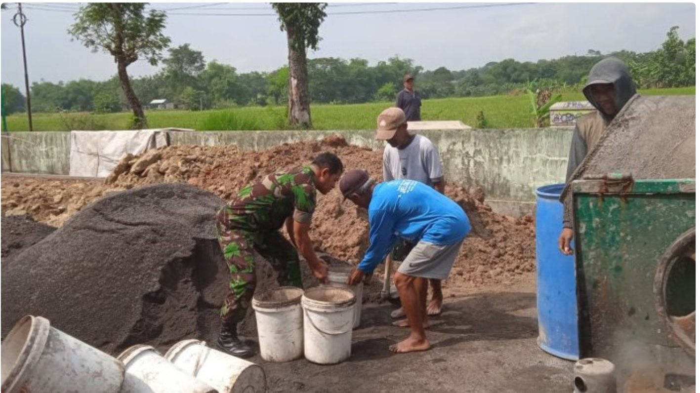
Wujud Kemanunggalan, Babinsa Wonosari Bantu Rehab Gedung Balai Desa Jelobo
