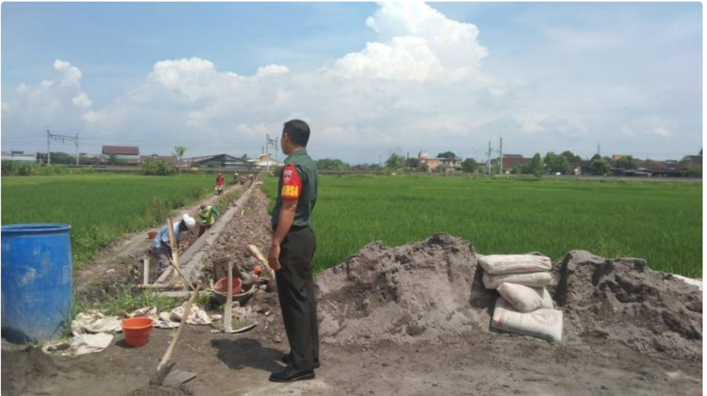
Pengerjaan Saluran Irigasi, Babinsa Ceper Lakukan Monitoring
